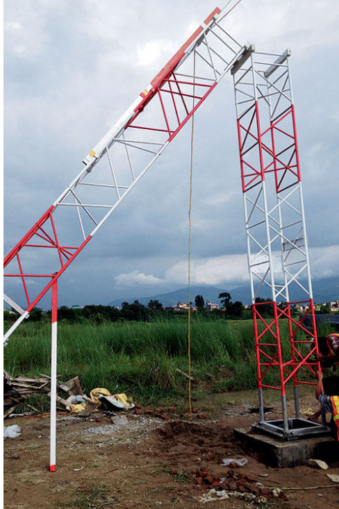
Torre frangível, da Ercon
