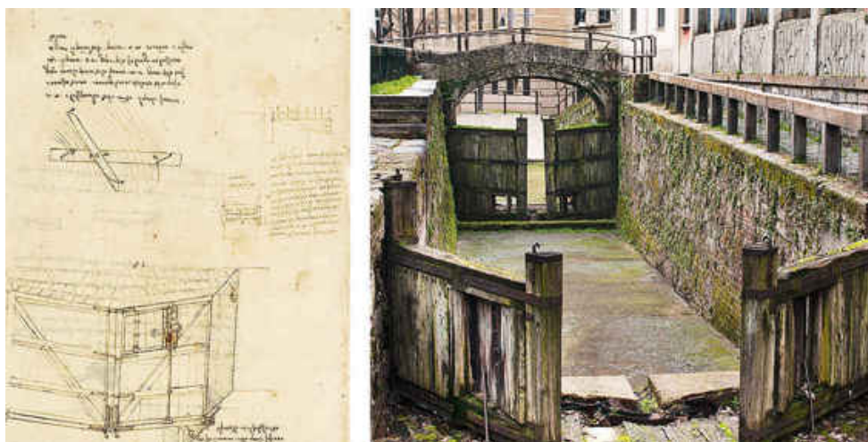
O esboço de Da Vinci para as comportas de um canal e comportas em Milão construídas segundo seu projeto
